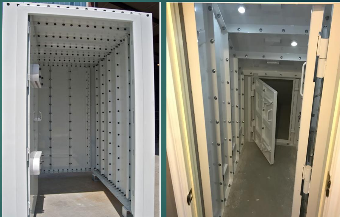
Pav. Pertvarų stiprinimui naudojami plieniniai skydai
