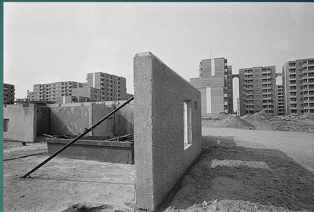
Pav. Stambiaplokščio namo statyba
