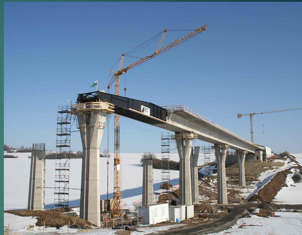
Pav. Inžinerinis statinys - estakada
